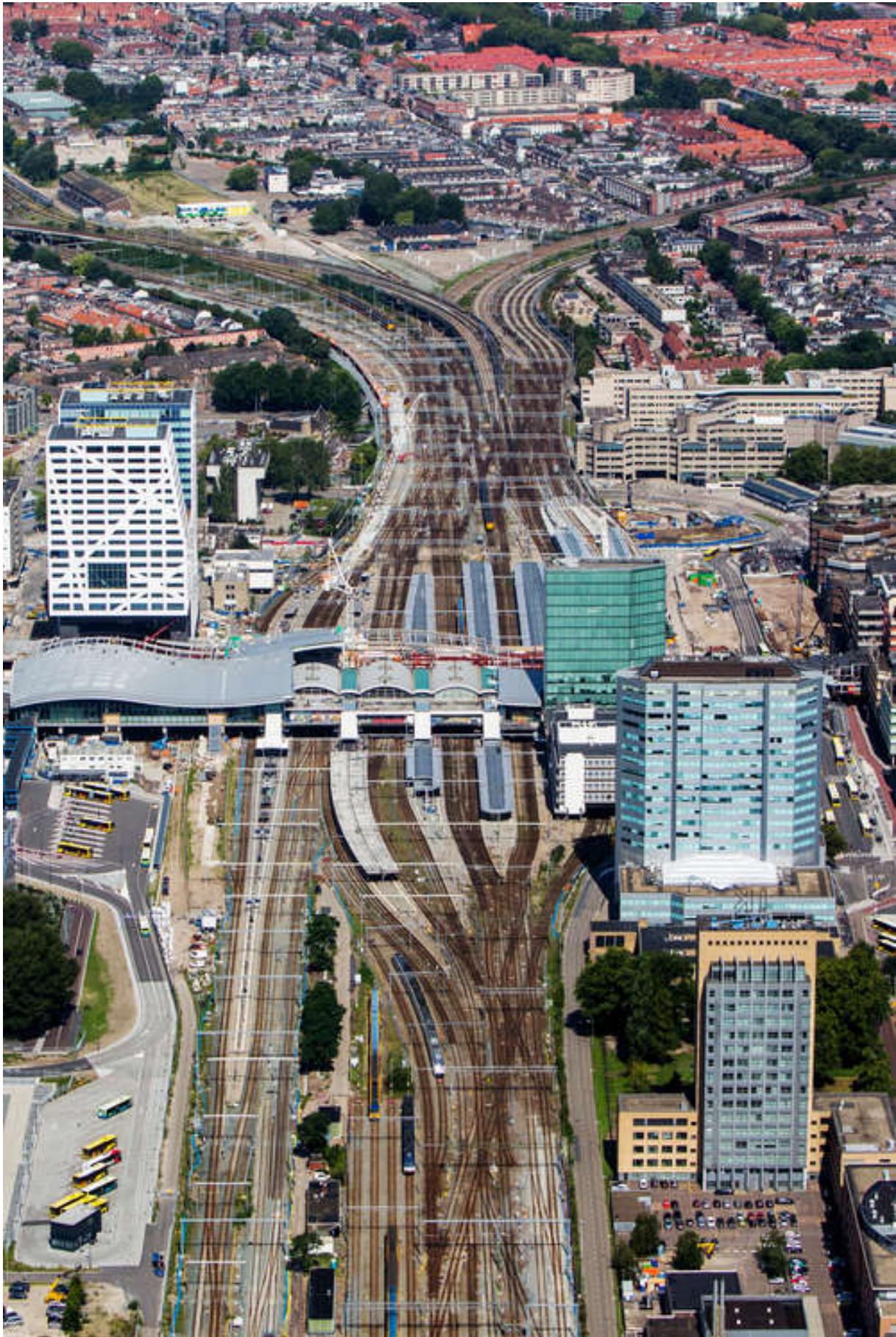
FOTO SHODY CAREMAN - Utrecht Centraal vanuit de lucht. Sinds het weekend werken hier dagelijks 400 mensen aan de spoorvernieuwing. In 9 dagen wordt ruim 2 kilometer spoor aan de noordkant van het station vernieuwd (linksboven op de foto). De megaklus is onderdeel van de 'ontvlechting van het spoor', waarbij 130 van de 200 wissels verdwijnen. Daardoor kunnen meer treinen sneller het station aandoen. Treinreizigers moeten tot zondag rekening houden met een aangepaste dienstregeling.
