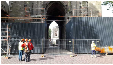
Inrichting van de bouwplaats rond de Domtoren.
