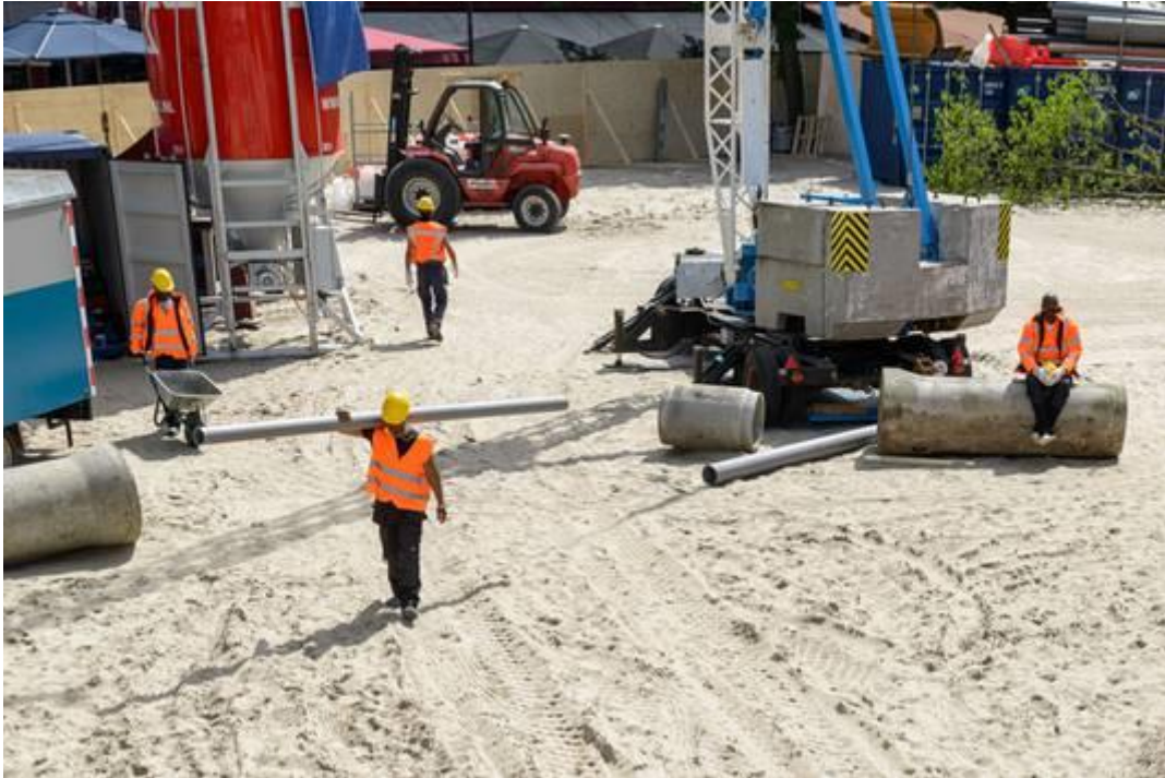
'Bouwvakkers' aan het werk op de (fictieve) bouwplaats op de Neude - een installatie van kunstenaar Dries Verhoeven. © Willem Populier
