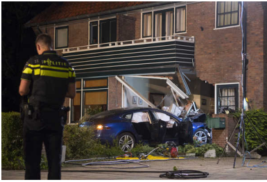
Door de botsing met de gevel ontstond een grote ravage.
