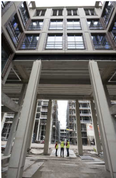
Leidsche Rijn Centrum in aanbouw. FOTO MARNIX SCHMIDT
