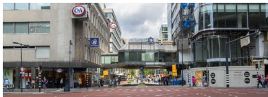
De sloop van de traverse boven de St.-Jacobsstraat begint maandag.
