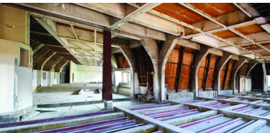
Binnen in het voormalige postkantoor is al veel werk verricht, zoals hier in een van de zolderruimtes.' BRON A.S.R.
