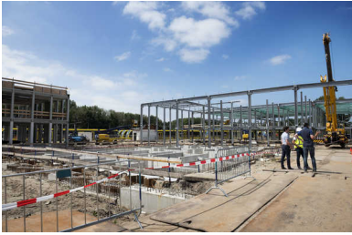
De nieuwe tramremise in wording. Gisteren is het hoogste punt bereikt. FOTO'S MARNIX SCHMIDT
