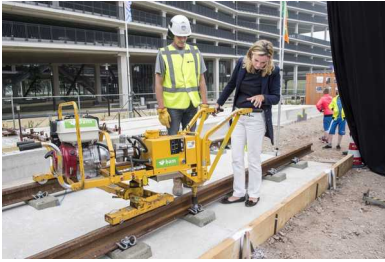
Gedeputeerde Verbeek-Nijhof plaatst een spoorstaaf bij de start van de aanleg in 2016.
