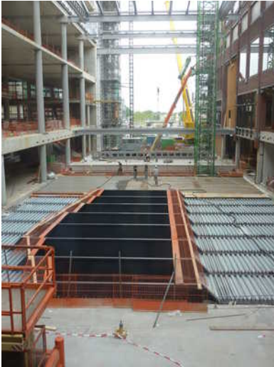
De Stadskamer in aanbouw. Door de zwarte balken moet het water zichtbaar blijven.
