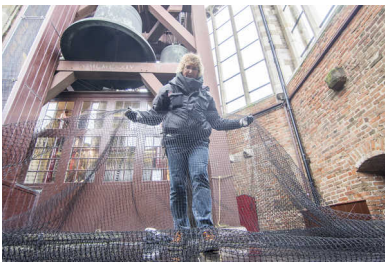
Claudia Kusters van Kusters Bird Control brengt de netten aan op 70 meter hoogte in de Domtoren.
